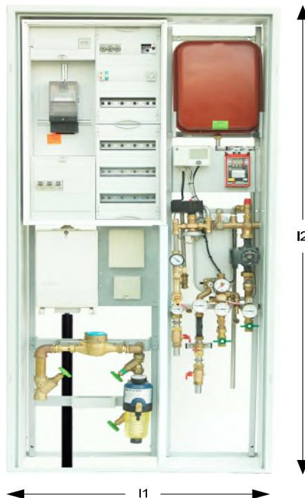
**Abbildung 7 — Darstellung einer Hausanschlussnische**
